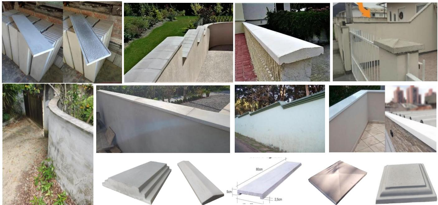
A capa de muro deve ser instalada com alinhamento, retificando as imperfeições da cabeça do muro ou da sua base, respeitando o alinhamento dado por uma linha de pedreiro.
